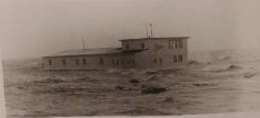
Bootshaus bei Sturmflut, 1962 – Die Sturmflut am 16. Februar 1962 setzte den Pfahlbau auf eine harte Probe. Das Gebäude war den anrollenden Wellen schutzlos ausgesetzt, doch die Schäden blieben überschaubar.
